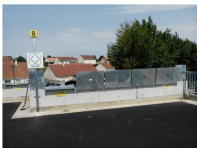
Mise en place d'un dispositif antichute
