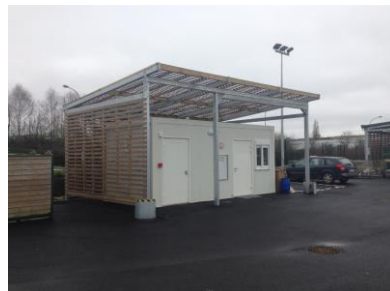
Remplacement du local gardien
