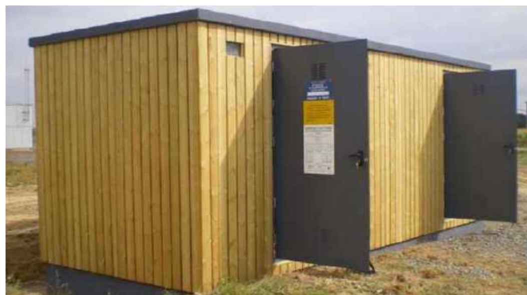
Photo 7 : Exemple de poste de livraison prévu sur le projet
