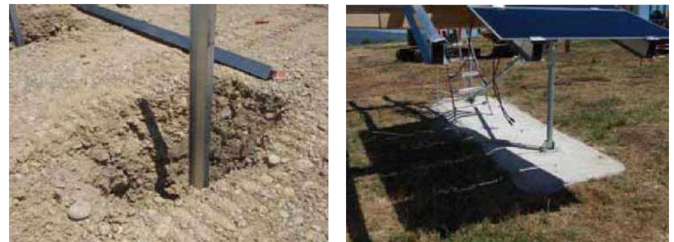
Photo 7 : Fondation avec pieux acier (à gauche) et fondation avec semelle béton (à droite)
