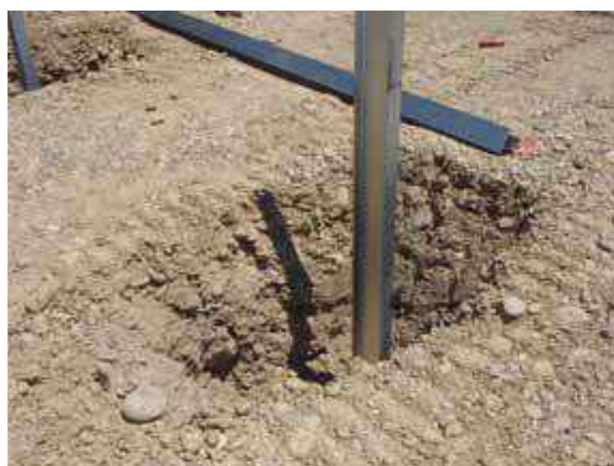
Photo 108 : Exemple de pieux en acier (Source : Guide de l'étude d'impact 2011)
