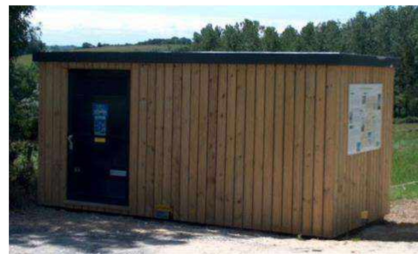
Photo 6 : Exemple d'un poste de livraison
