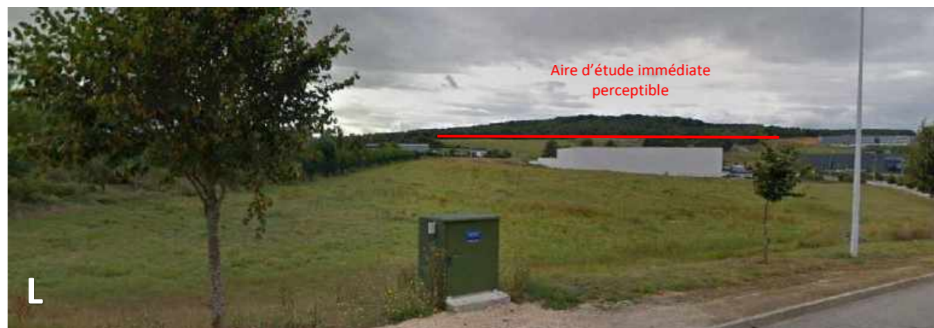
Photo 79 : Depuis une voie de desserte de la ZA de l'Aunay, le site est perceptible (Source photo : Google Street View)
