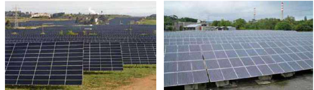
Photo 1 : Installations fixes au sol
