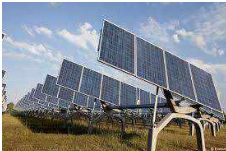
Photo 4 : Suiveurs à rotation bi-axiale
