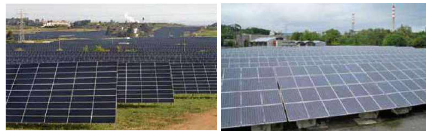
Photo 2 : Installations fixes au sol
