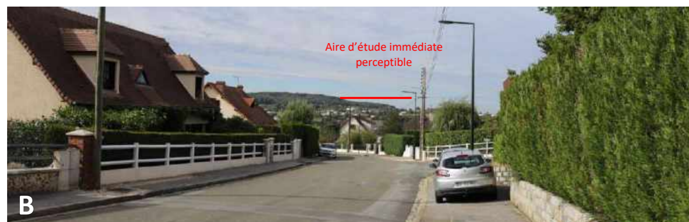
Photo 68 : Vue lointaine sur le site du projet depuis le lieu-dit de Bellevue (Source : AEPE-Gingko)
