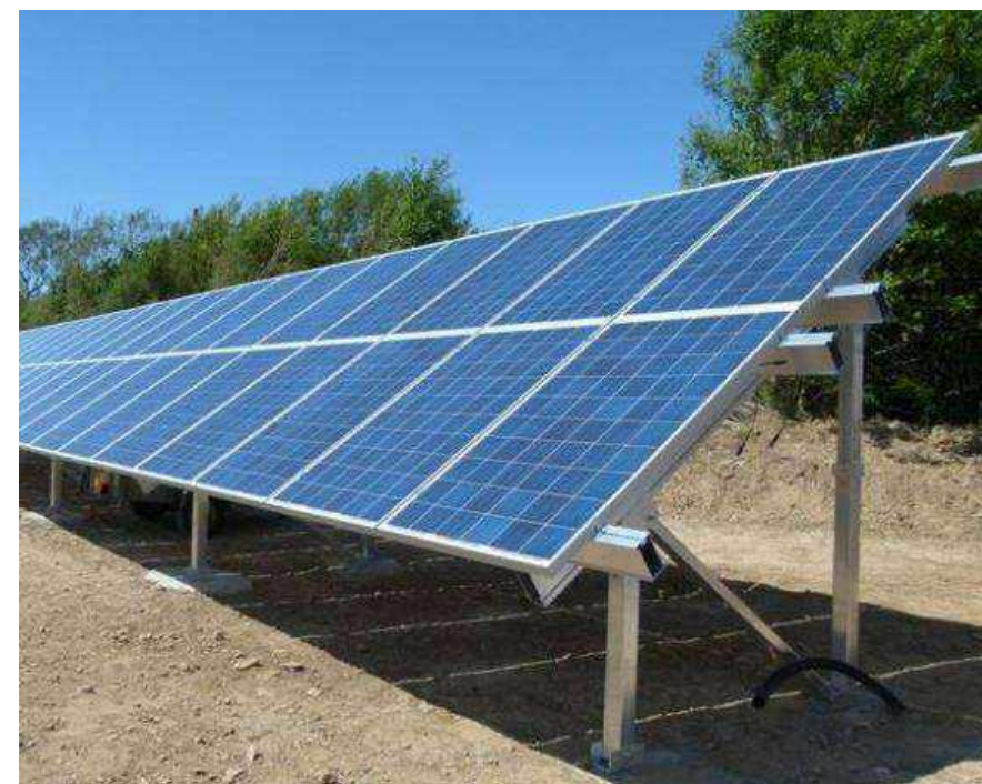
Photo 107 : Exemple de structures photovoltaïques
