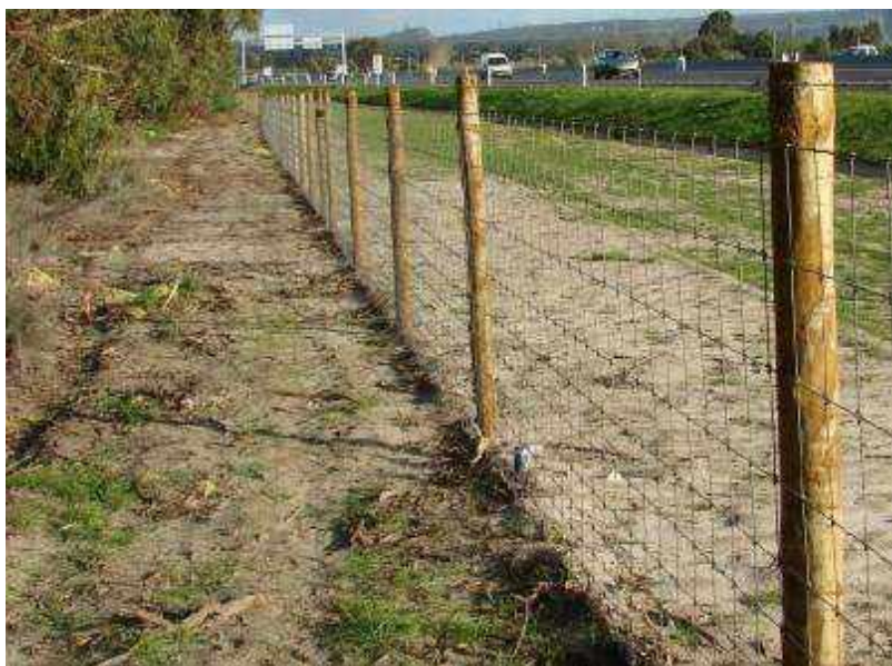
Photo 110 : Exemple de clôture avec grillage mouton et piquets en bois
