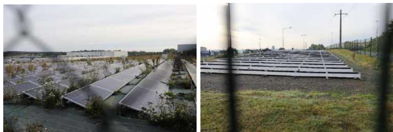
Photo 73 : Des installations photovoltaïques à côté du site du projet (Source : AEPE-Gingko)
