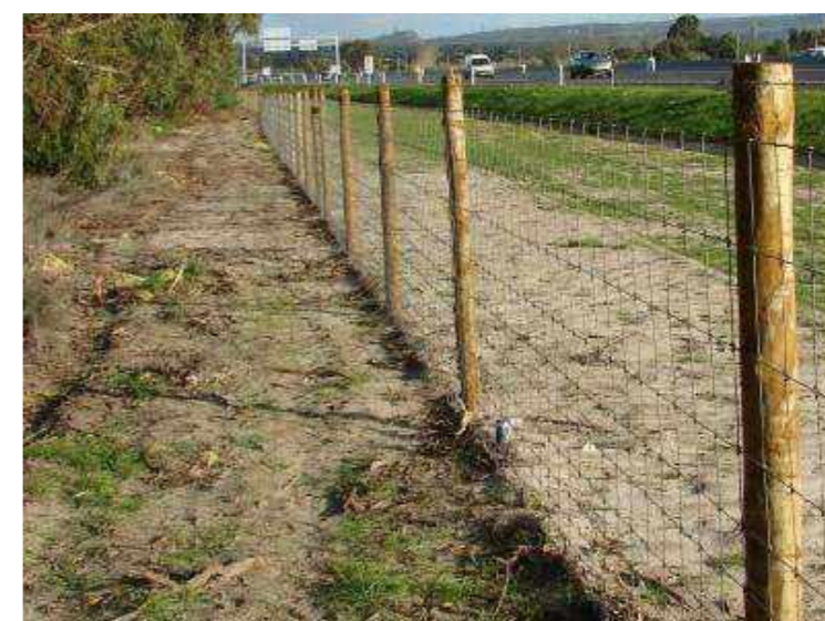
Photo 8 : Exemple de clôture avec grillage mouton et piquets en bois
