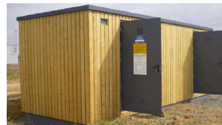
Photo 109 : Exemple de poste de livraison prévu sur le projet
