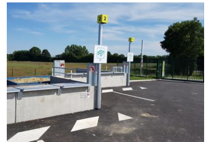
Mise en place d'une nouvelle Signalétique + dispositif antichute
