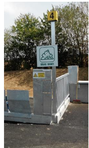
Mise en place d'une nouvelle Signalétique
