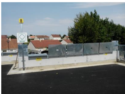
Mise en place d'un dispositif antichute
