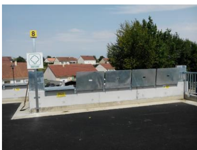
Mise en place d'un dispositif antichute
