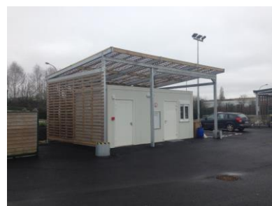
Remplacement du local gardien
