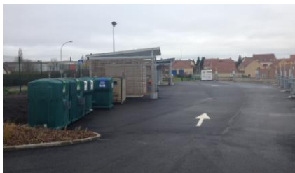
Création de 4 nouveaux quais Création d'une entrée et une sortie VL distincte avec un sens de circulation
