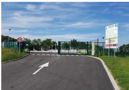
Création de 4 nouveaux quais Création d'une entrée et une sortie VL distincte avec un sens de circulation
