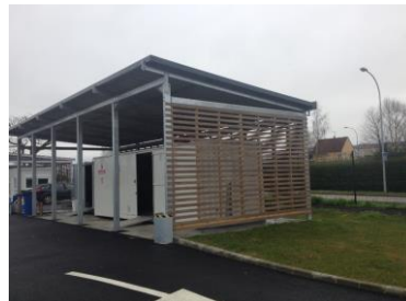
Nouvelle zone couverte pour le stockage des déchets toxiques
