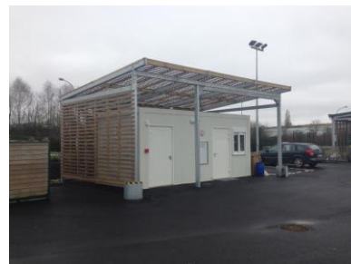
Remplacement du local gardien
