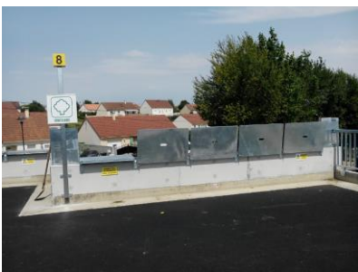
Mise en place d'un dispositif antichute
