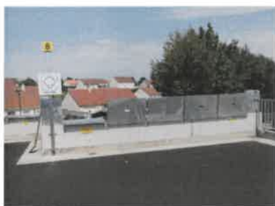
Mise en place d'un dispositif antichute
