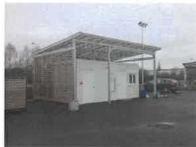
Remplacement du local gardien
