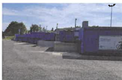
Réhausses des bennes gravats
