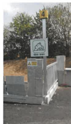
Mise en place d'une nouvelle signalétique
